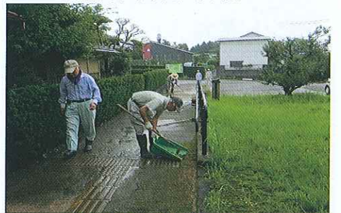
記念館玄関前舗装修理
